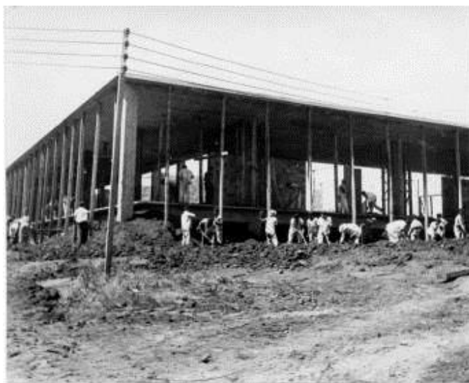
Figura 14 – Operários trabalhando na construção do primeiro prédio da UnB. Fonte: Acervo CEDOC/UnB/foto 112-6.
